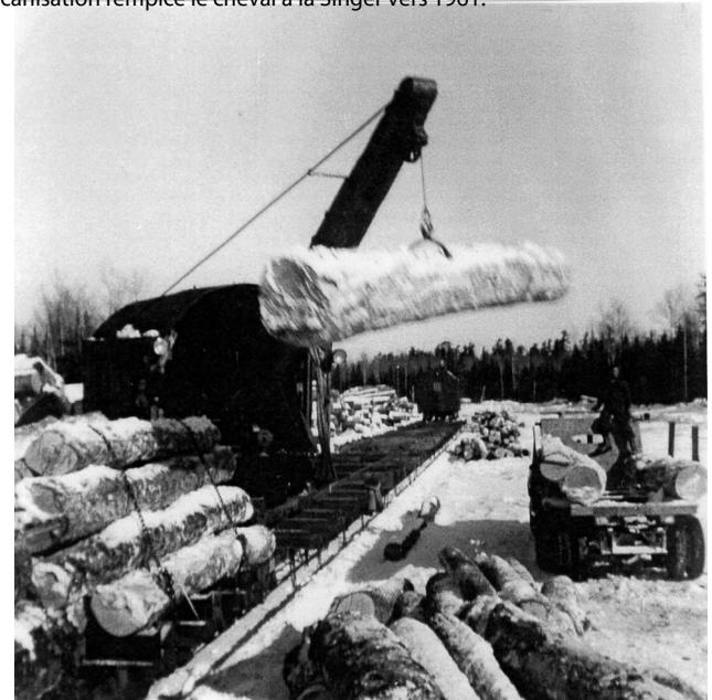
Le chargeur circulait sur des rails fixées aux wagons et pouvait passer d'un wagon à l'autre tout en déchargeant les camions ou prendre les billes des emplacements du dépôt pour le transport vers l'usine de Thurso.
