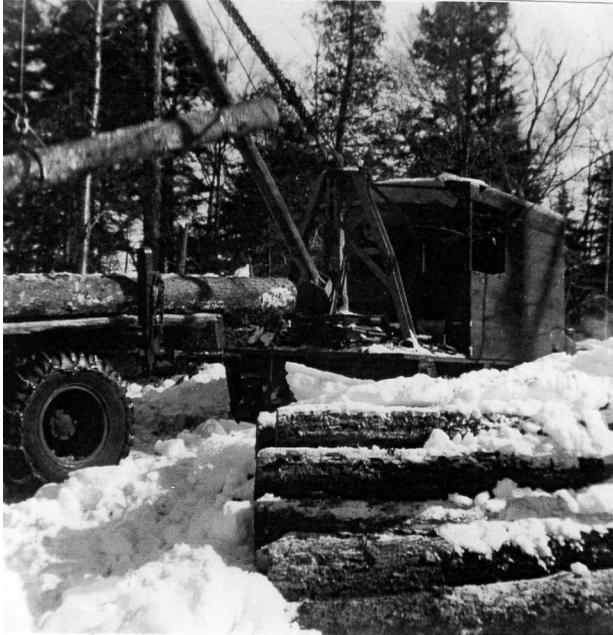
Le chargement d'un camion sur un site de coupe pour le transport au dépôt le long de la voie ferrée vers les années 1950 à la Singer.
