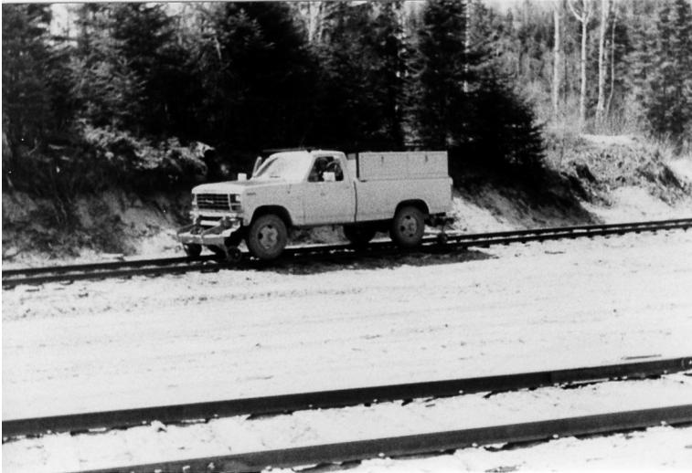
Petit camion Ford équipé de roues spéciales lui permettant d'emprunter les rails du chemin de fer afin de se promener pour inspecter et entretenir la voie ferrée.
