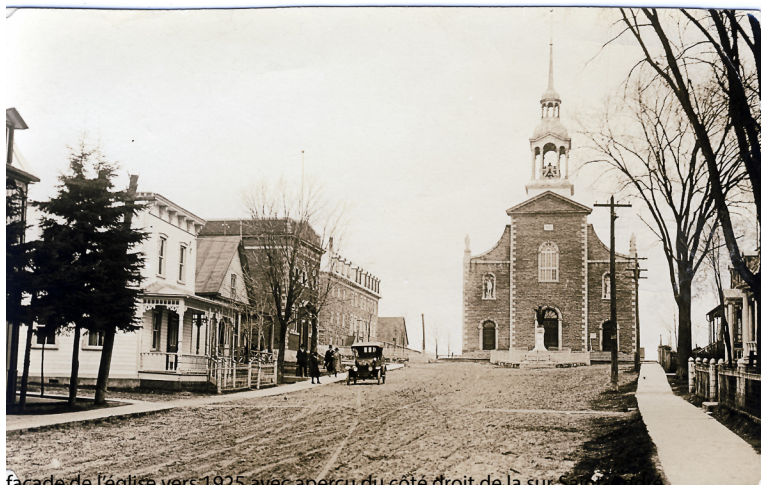
façade de l'église vers 1925 avec aperçu du côté droit de la sur Saint-André
